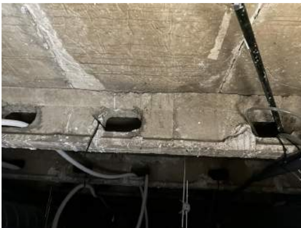
Figura 1. Forjat tipus 1 (secció transversal i longitudinal) – Biguetes amb alvèols
